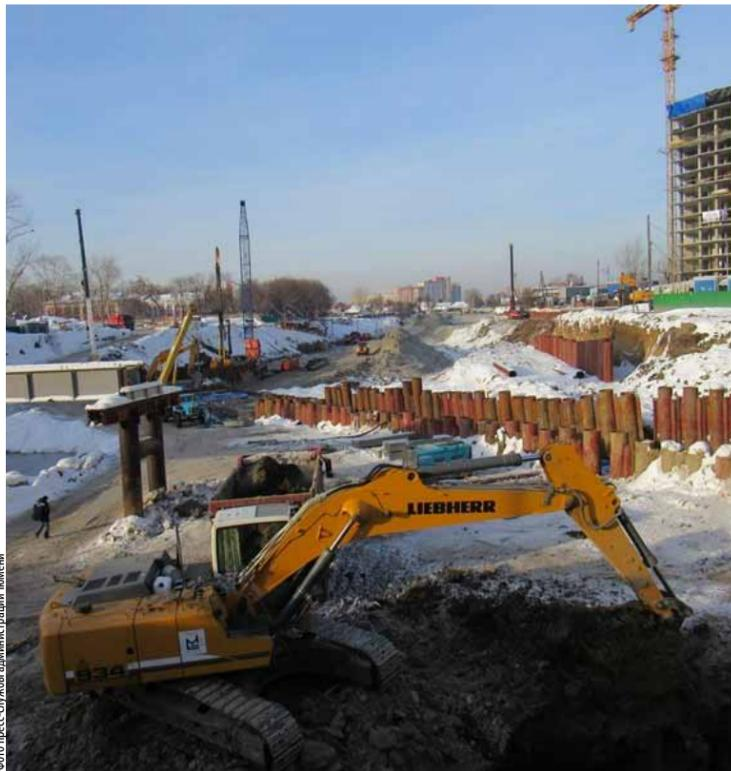
Строительство дороги на улице Запольной идет по плану. Заканчивается прокладка бетонного русла реки под дорогой, по которому в феврале пустят реку Тюменку. Строятся съезды, ведутся работы по уплотнению грунта.
